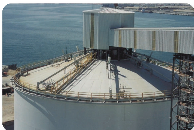
Enchimento anti-segregação Antisegregation silo filling Relleno anti-segregación
