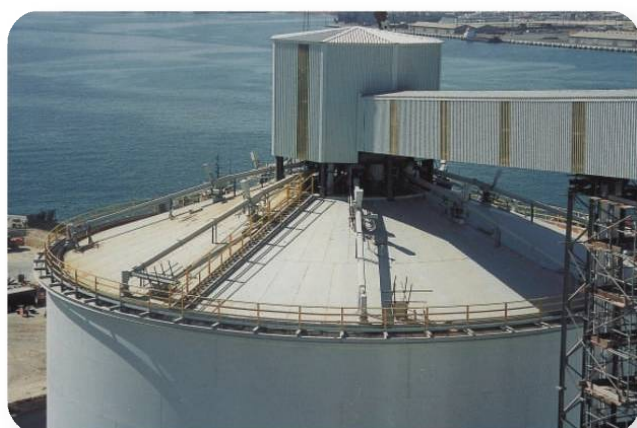
Enchimento anti-segregação Antisegregation silo filling Relleno anti-segregación
