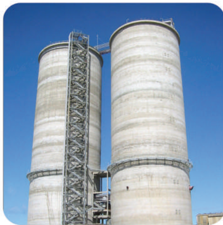
Silos monocâmara para exportação de cimento. Monocamera silos for exporting of cement. Silos monocamara para exportación de cemento.
