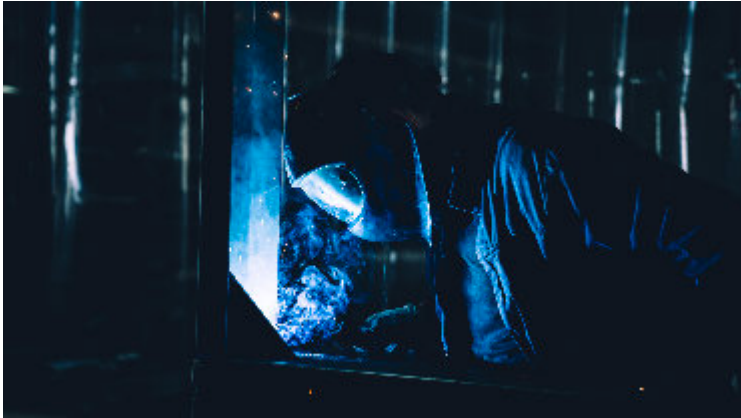
Soldagem de vaso de pressão na planta da Zeppelin Systems Welding on pressure vessel at Zeppelin Systems' plant Soldadura de estanque de presión en la fábrica de Zeppelin Systems
