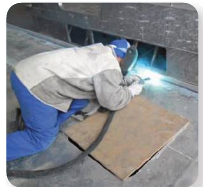
Soldadores qualificados Skilled welders Soldadores calificados
