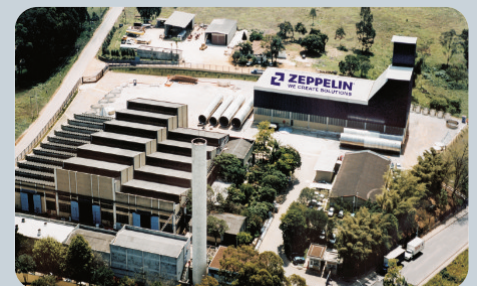
Vista aérea da fábrica Plant overview Vista aérea de la fábrica
