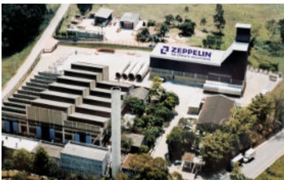
Vista aérea da fábrica / Plant overview Vista aérea de la fábrica
