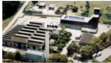
Vista aérea da fábrica / Plant overview Vista aérea de la fábrica
