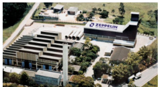
Vista aérea da fábrica / Plant overview Vista aérea de la fábrica
