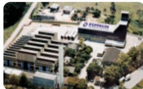
Vista aérea da fábrica. Plant overview. Vista aérea de la fabrica.
