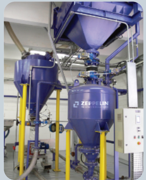
Centro de Testes Test Center Centro Tecnológico
